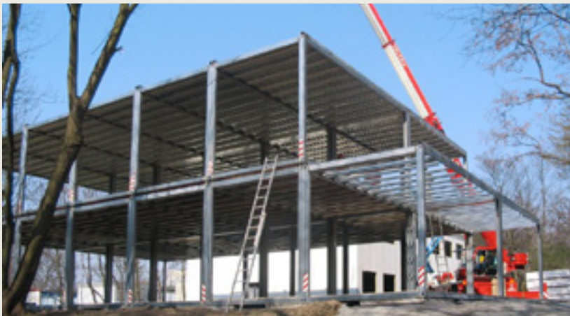
In wenigen Tagen: Von der Rohkonstruktion zum befristet genutzten Eventgebäude.
